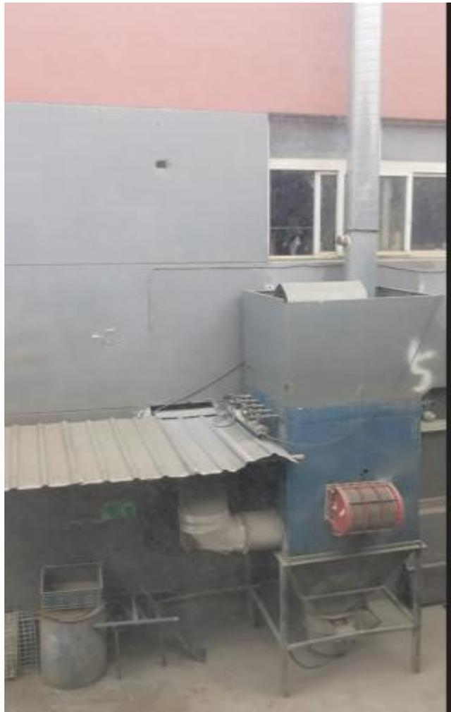
生产车间 4 号生产线喷涂间侧吸排风设施
